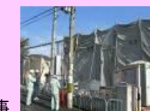
アスベスト解体工事
