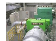
発電施設を併設した焼却施設
