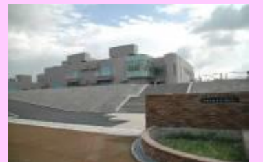
水みらいセンター (下水処理場)
