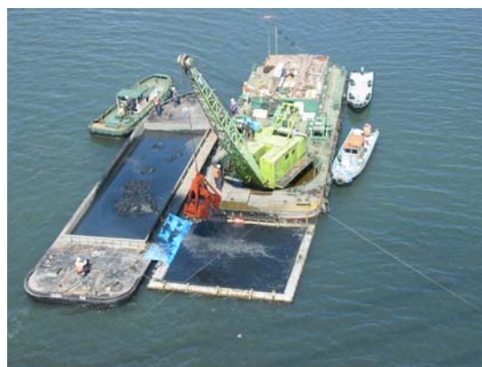
< 神崎川ダイオキシン類浄化対策浚渫状況写真 >
