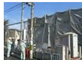
アスベスト解体現場 パトロール
