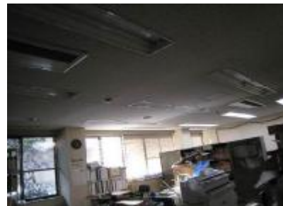
執務室の部分消灯
