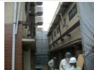
解体現場パトロール
