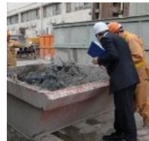
汚染土壌掘削工事の現地確認状況
