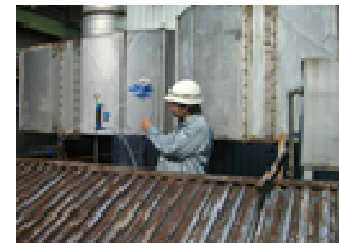
検査のために処理施設から排ガス採取
