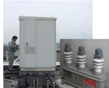
PCB（コンデンサ）保管状況の立入検査
