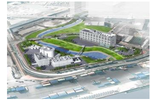
整備中の大型蓄電池試験・評価施設（NLAB）
