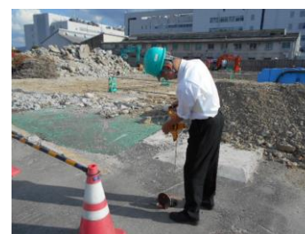
汚染土壌掘削工事の現地確認状況(地下水位の確認)
