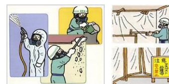
アスベスト除去工事（イメージ）
