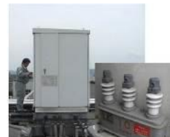
PCB廃棄物（コンデンサ）保管状況の立入検査
