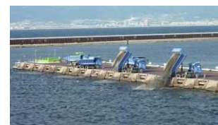
フェニックス処分場での 廃棄物受入
