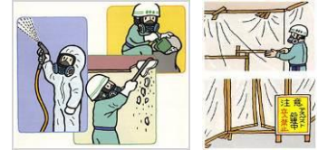
アスベスト除去工事（イメージ）
