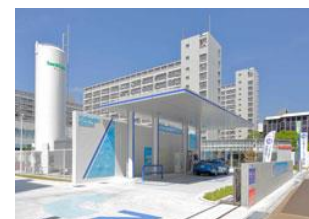
情報発信拠点を併設した 水素ステーション （大阪市城東区）
