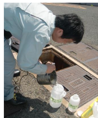
事業所排水の採水検査
