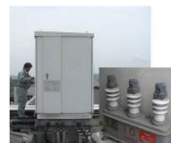
PCB廃棄物(コンデンサー)に係る立入検査
