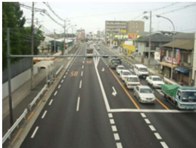
図-19 府道 京都守口線（守口市金田町付近）
