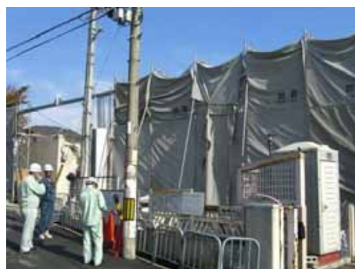
図-32 解体現場パトロール
