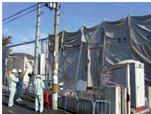
図-35 解体現場パトロール
