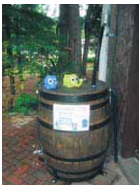
図一31 府立花の文化園内に設置された 雨水タンク
