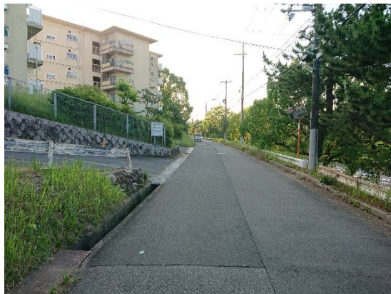
南東方より調査対象地
