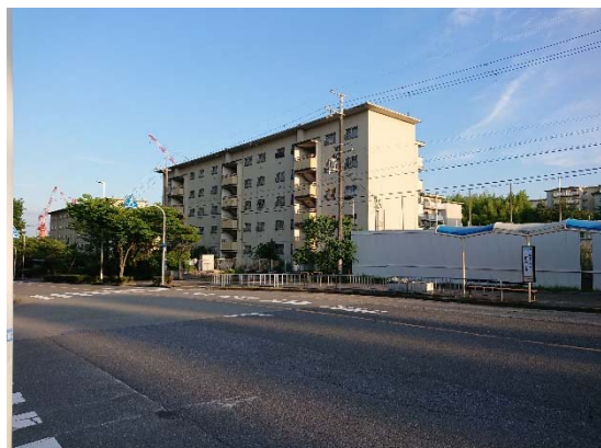
北西方より調査対象地
