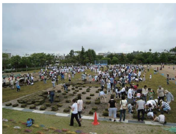
図-35 芝張り作業の様子
