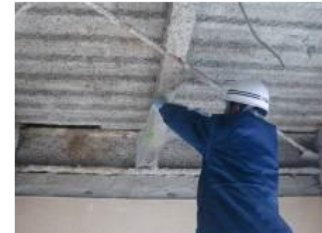
解体現場立入検査
