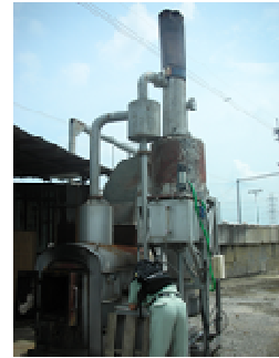
特定施設の現地確認状況
