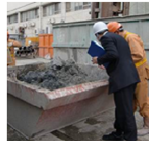
汚染土壌掘削工事の 現地確認状況
