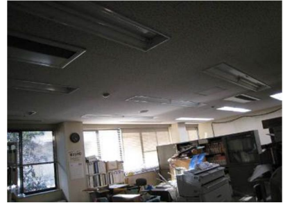
執務室の部分消灯
