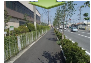
民有地沿道部と街路樹を一体的に整備
