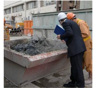
汚染土壌掘削工事の 現地確認状況
