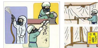
アスベスト除去工事（イメージ）
