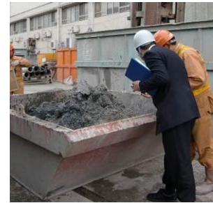
汚染土壌掘削工事の 現地確認状況
