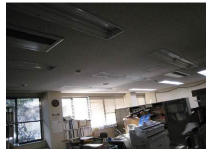
執務室の部分消灯
