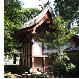
有形文化財（建造物）
