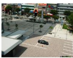
透水性・保水性舗装
