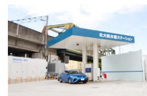
北大阪水素ステーション
