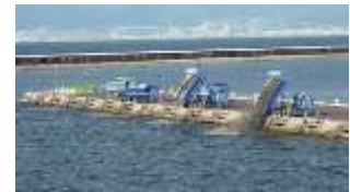
フェニックス処分場での 廃棄物受入
