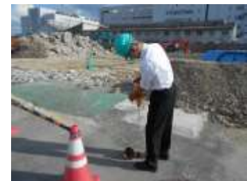
汚染土壌掘削工事の現地確認状況（地下水位の確認）
