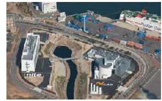
大型蓄電池システム試験評価施設（NLAB）
