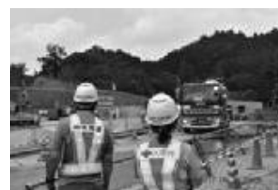
流入車規制の立入検査
