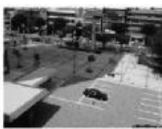
透水性・保水性舗装
