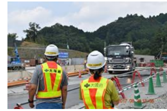
流入車規制の立入検査
