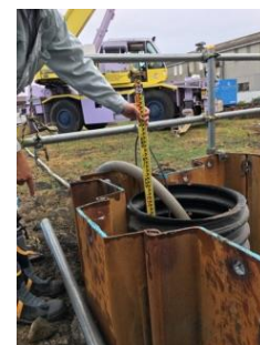
汚染土壌掘削工事の現地確認状況（地下水位の確認）
