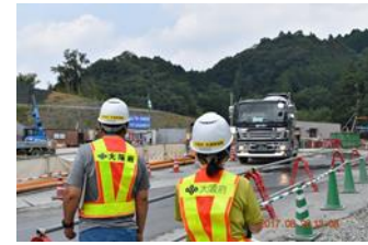
流入車規制の立入検査
