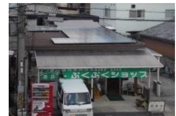
障がい者作業所に設置
