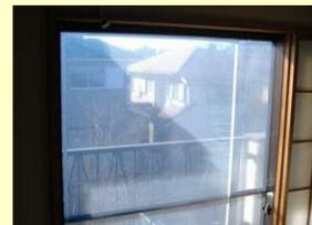
写真10 窓への断熱シートの貼付け※30
