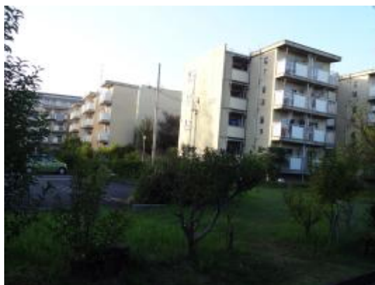
南東方より調査対象地
