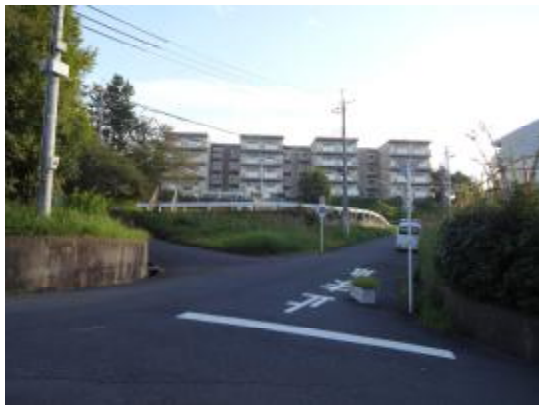
北西方より調査対象地
