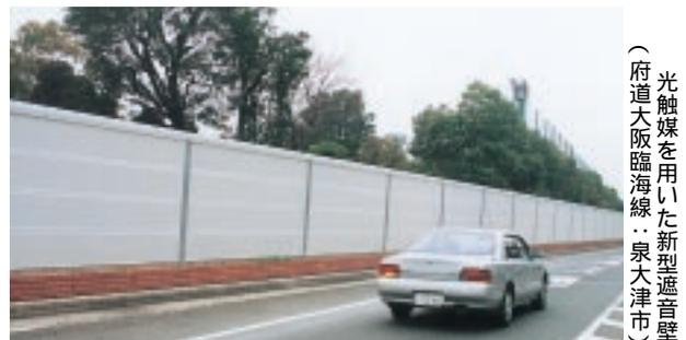
(府道大阪臨海線・泉大津市) 光触媒を用いた新型遮音壁
