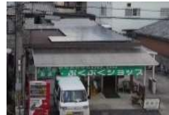
障がい者作業所に設置
