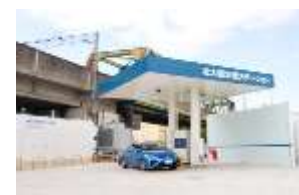
北大阪水素ステーション
