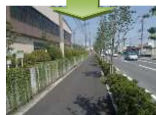
民有地沿道部と街路樹を一体的に整備
