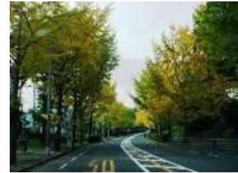
樹木更新を行った後の街路樹整備状況(2011 年度 府道豊中摂津線)
