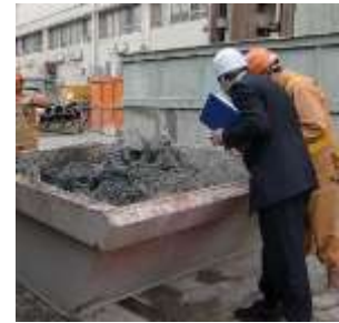
汚染土壌掘削工事の 現地確認状況
