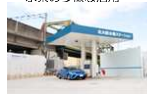
北大阪水素ステーション
