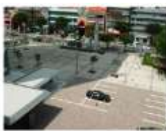
透水性・保水性舗装
