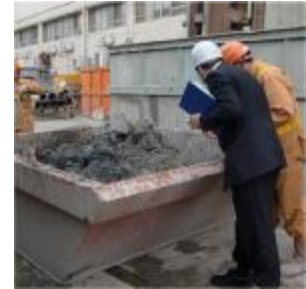
汚染土壌掘削工事の 現地確認状況
