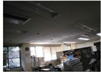
執務室の部分消灯
