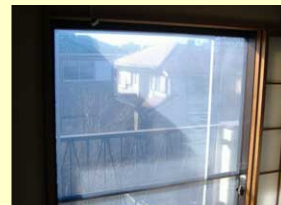
写真10 窓への断熱シートの貼付け※30
