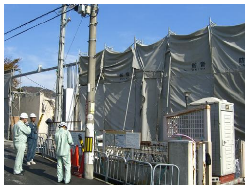
アスベスト解体現場パトロール
