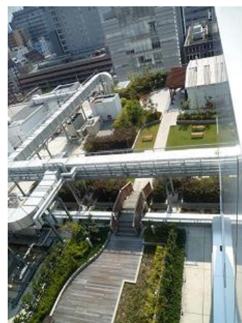
株式会社大西本社ビル
