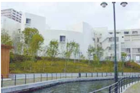
図 - 36 森之宮医療大学(大阪市住之江区)の緑化状況
