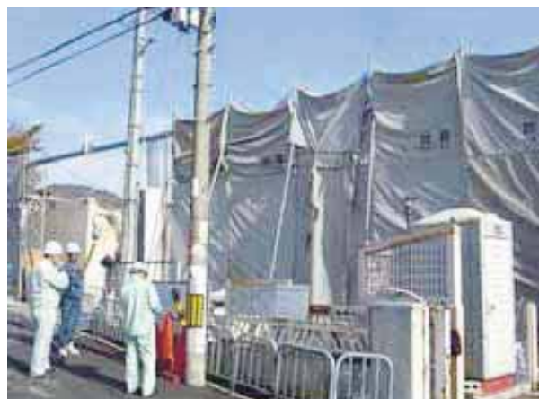
図-32 解体現場パトロール
