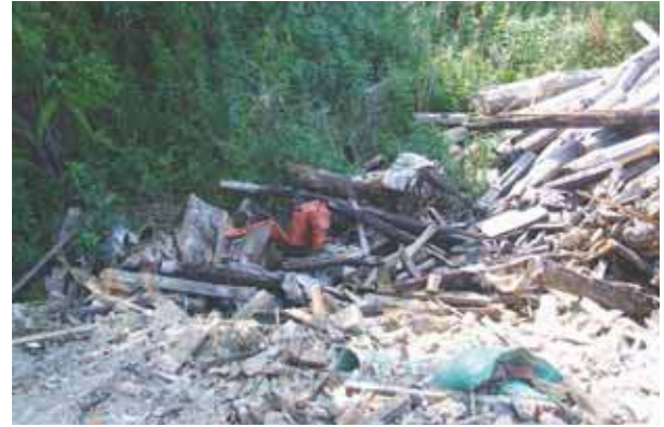
図-25 産業廃棄物の不適正処理現場
