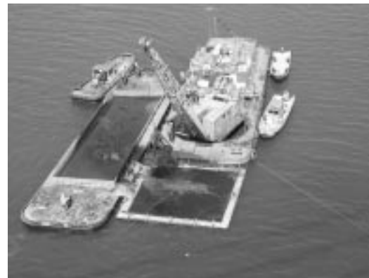
<河川の浚渫の様子>
