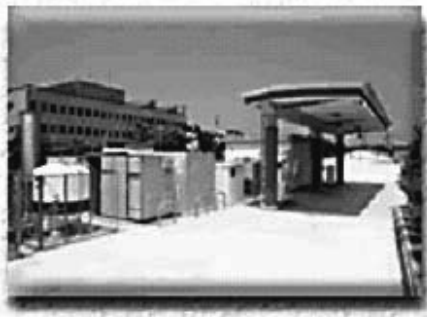
<燃料電池自動車と水素ステーションについて>
