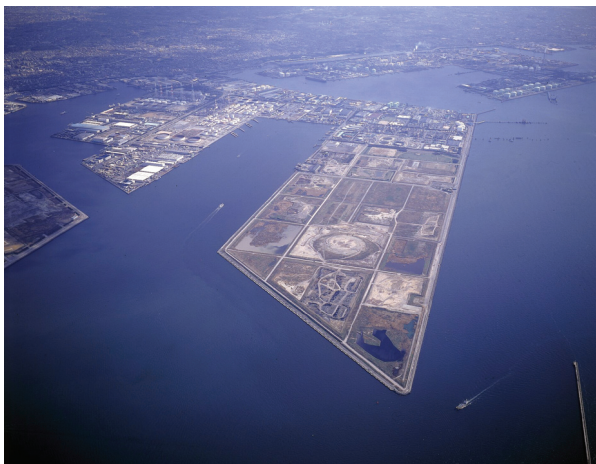
図-5 堺第7-3区処分場跡地の航空写真
