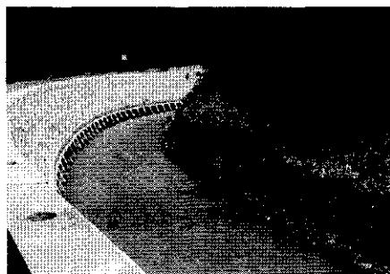
[天王川の河川改修等に際し、オオサンショウウオの生息空間を確保するため、コンクリートブロックなどにより巣穴を設置した施工例]
