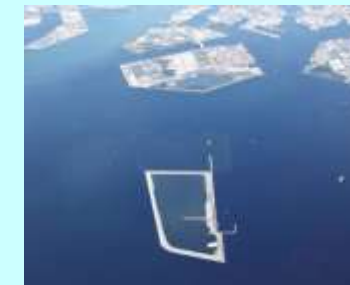
フェニックス計画 大阪沖埋立処分場
