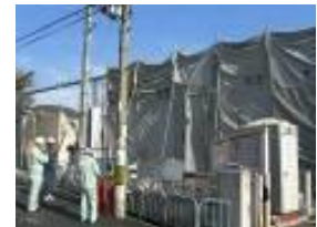
アスベスト解体現場 パトロール
