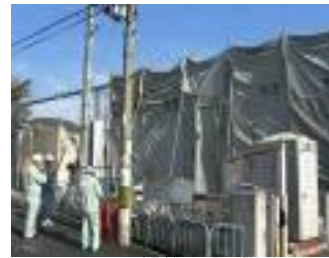
アスベスト解体現場パトロール
