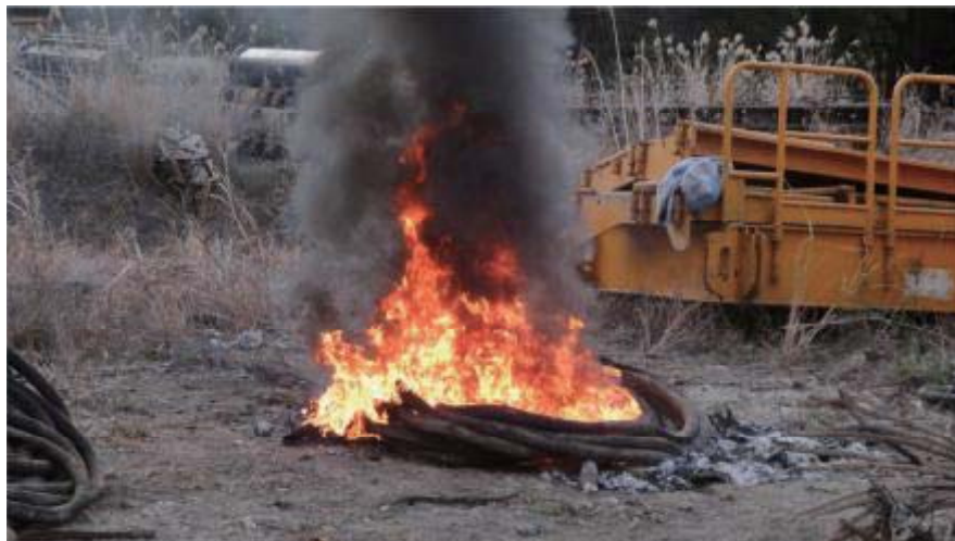
図 2-5 産業廃棄物の不適正処理現場
