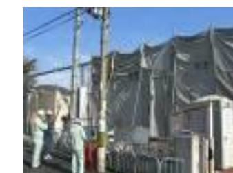
アスベスト解体現場パトロール
