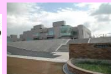
水みらいセンター (下水処理場)
