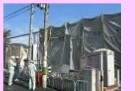
アスベスト解体現場パトロール
