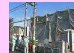
アスベスト解体現場パトロール
