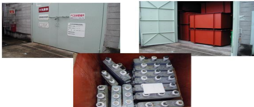
図4 PCB廃棄物保管例
