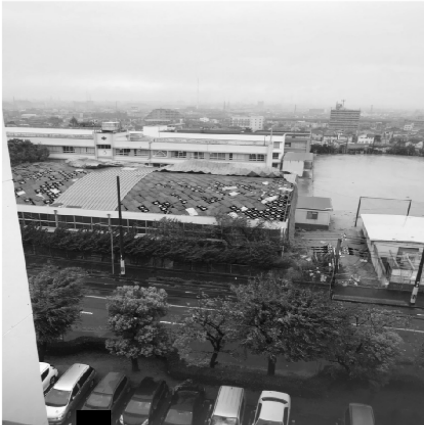
↑ 飛散した体育館の屋根
