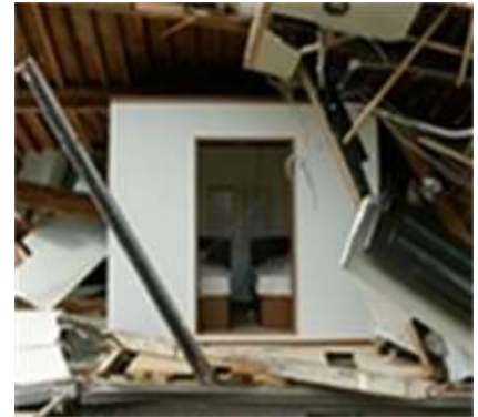
(耐震シェルターの例)
