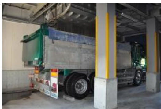
上部のバンカが開き、ダンプカーに焼却灰が積込まれる。
