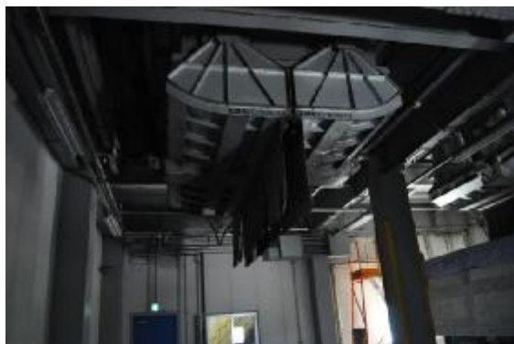
バンカ：焼却灰を一時貯留し、適時ダンプカー積込む
