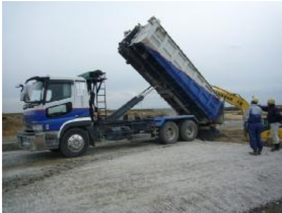
<主灰の埋め立ての様子>
