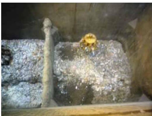
<ごみピットの様子>
